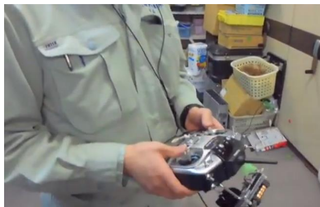
地上における有資格者の操作 及び打音診断の様子
