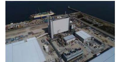
伏木万葉埠頭バイオマス発電所
