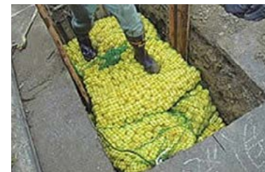
「ECOボール」を利用した導管工事
