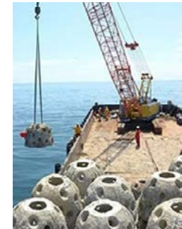
人工リーフボールの設置作業 出典：Petronas, “Bringing life to a barren ocean”
