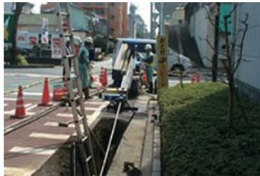
ガス管を埋設するための立坑
