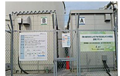
横浜市北部汚泥資源化センターに設置したバイオガス精製試験装置
