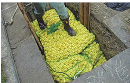
「ECOボール」を利用した導管工事
