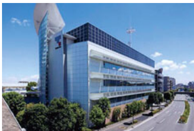
アースポートの建物外観（改修後）
