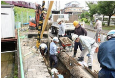
復旧作業の様子
