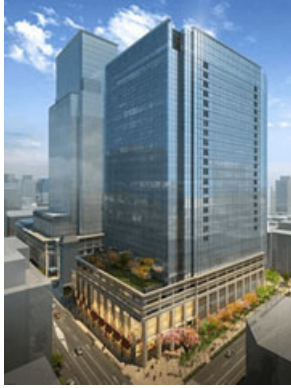
日本初の既存街区へのエネルギー供給 日本橋室町
