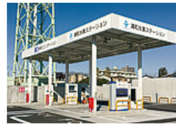
浦和水素ステーション
