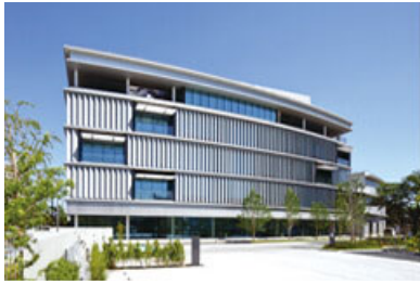
アースビル立川の建物外観
