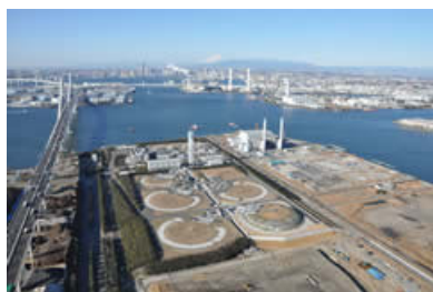
扇島LNG基地
