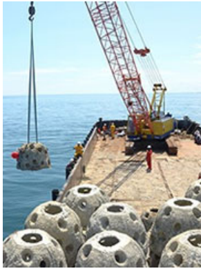
人工リーフボールの設置作業
