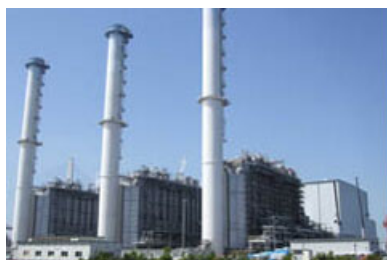
現在の扇島パワーステーション
