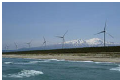
遊佐風力発電所の様子
