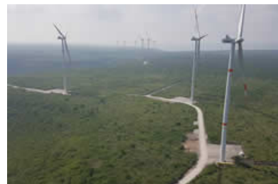
トレスメサス3発電所
