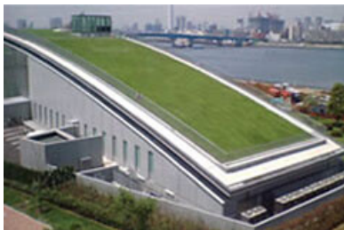
「がすてなーに ガスの科学館」の屋上
