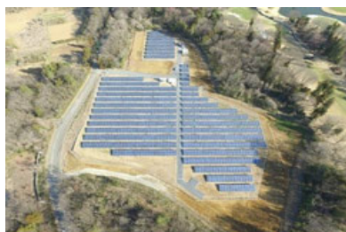
埼玉熊谷太陽光発電所の様子
