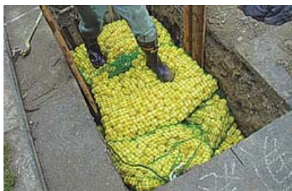
「ECOボール」を利用した導管工事
