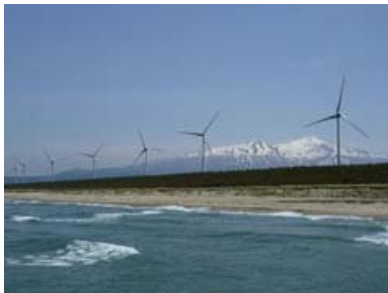
遊佐風力発電所の様子
