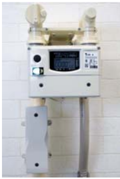
超音波式ガスメーター（上）とPHS通信端末（下）
