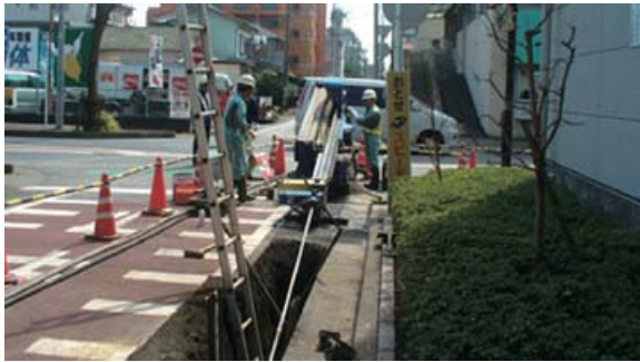
ガス管を推進するための立坑
