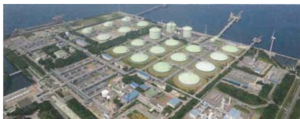
袖ヶ浦LNG基地
