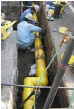
経年ガス管の取り替え
