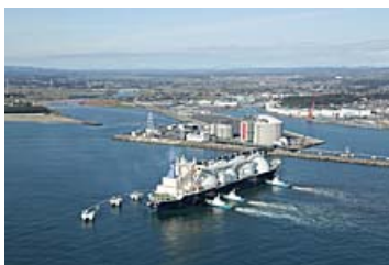
日立LNG基地
