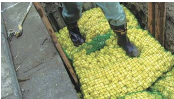
新型仮埋め戻し材「ECOボール」
