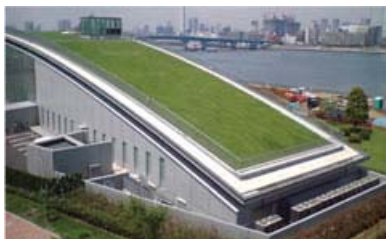
「がすてなーに ガスの科学館」の屋上
