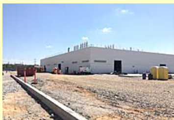
エネルギーサービス事業を行う工場
