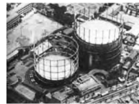
1974年頃のガス貯蔵設備/水式ホルダー
