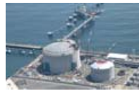
日立LNG基地
