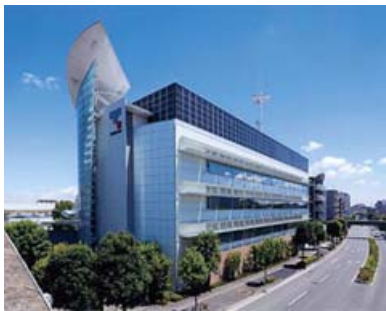
アースポートの建物外観（改修後）
