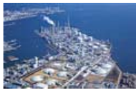
根岸LNG基地
