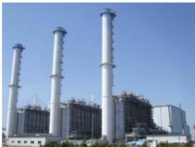
現在の扇島パワーステーション
