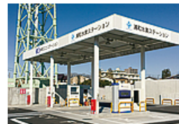
浦和水素ステーション
