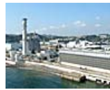
(株)東京ガス 須賀パワー
