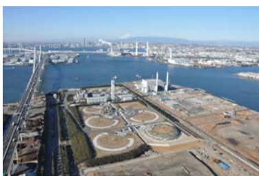
扇島LNG基地
