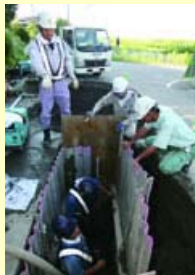
ガス復旧作業の様子
