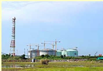
第二期工事中のマブタブットLNG基地
