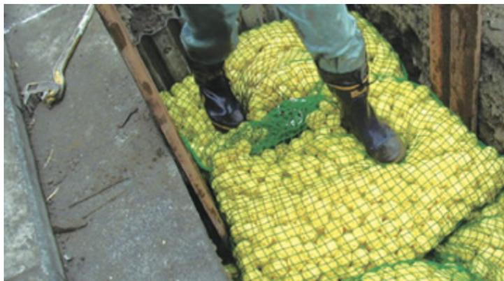
同一箇所を再掘削する場合に新型仮埋め戻し材「ECOボール」を採用し、山砂の利用を低減させています
