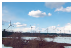
庄内風力発電(有)が運営する遊佐風力発電所
