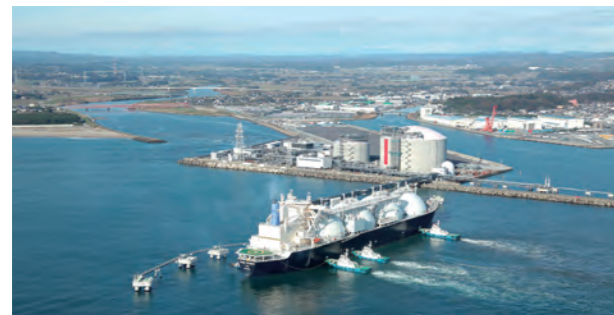
日立LNG基地
