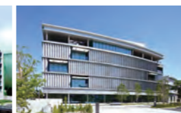
アースビル立川(TG立川ビル)
