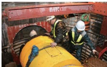
幹線工事の様子
