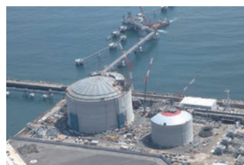
建設中の日立LNG基地 左: LNGタンク(23万kl) 右: LPGタンク(5万kl)
