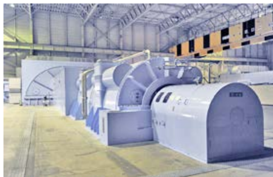
出力40万kWの省エネ性に優れたガスタービンコンバインドサイクル発電。 一般家庭の年間使用量の約80万件分に相当
