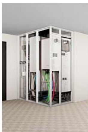
マンション向け「エネファーム」の設置レイアウトと外観（パイプシャフト内設置時）の例
