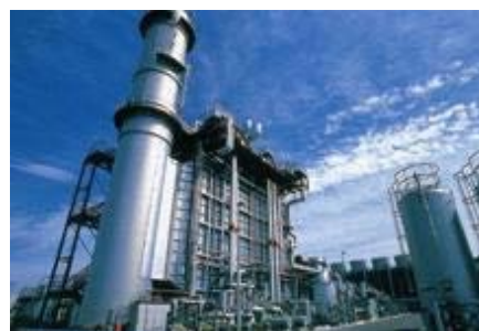
(株)東京ガスベイパワー袖ヶ浦発電所
