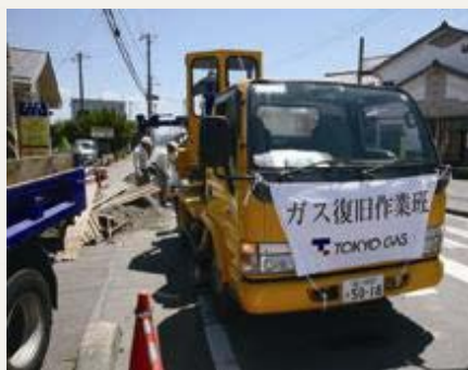
ガス復旧作業の様子
