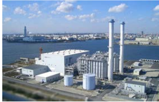
扇島パワーステーション全景
