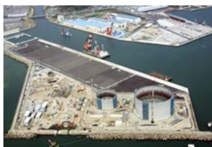
建設中の日立LNG基地
