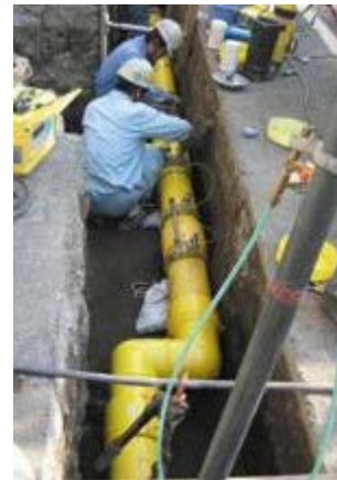
経年ガス管の取り替え
