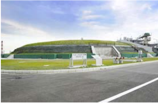
扇島工場の覆土式LNG地下タンク
