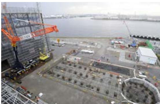
3号機建設が進む扇島パワーステーション
