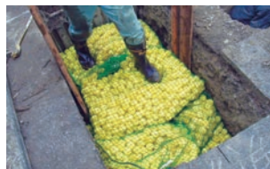
新しい仮埋め戻し材「ECOボール」を利用した導管工事
