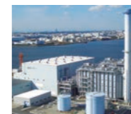
(株)扇島パワー発電所
