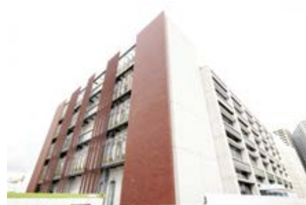
東京ガス平沼ビル（2013年3月竣工）
