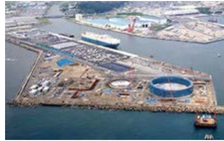
建設中の「日立LNG基地」
