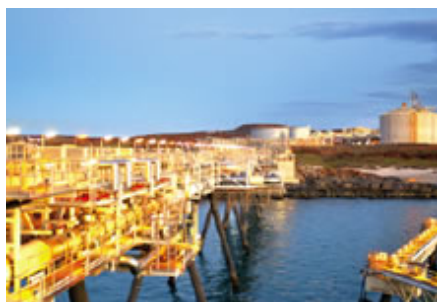
「プルートLNGプロジェクト」天然ガス液化基地
