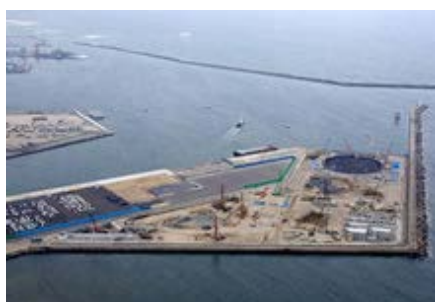
建設中の日立LNG基地
