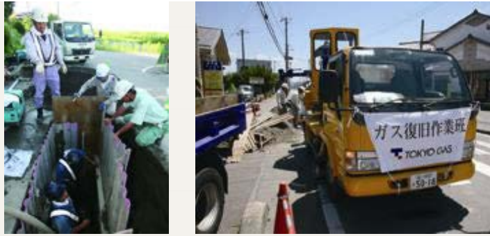
ガス復旧作業の様子
