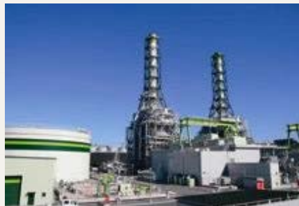
川崎天然ガス発電所
