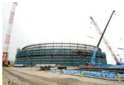
「日立LNG基地」に建設中のLNGタンク (2013年7月現在)
