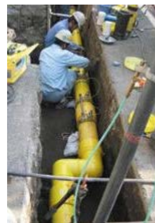
経年ガス管の取り替え
