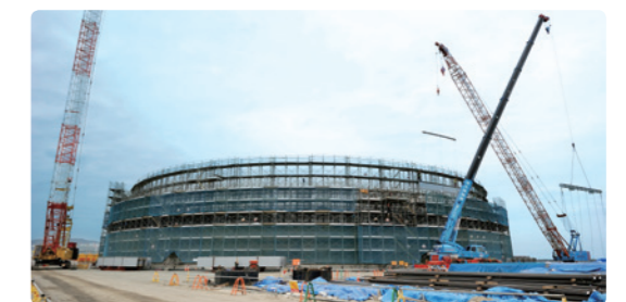
「日立LNG基地」に建設中のLNGタンク(2013年7月現在)
