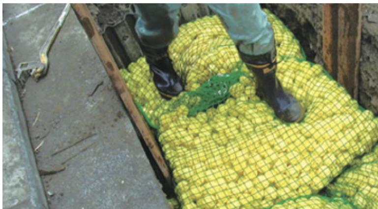
同一箇所を再掘削する場合に新型仮埋め戻し材「ECOボール」を採用し、土砂の利用を低減させています
