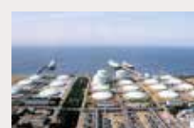
袖ヶ浦工場全景
