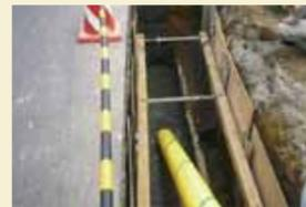
ガス管の埋設工事では掘削機が発生するため「浅層埋設」や「非開削工法」などの採用で、掘削土の減量化や発生土埋め戻し、改良土・再生路盤材の利用拡大などに取り組んでいます。これにより山砂などの採掘による生態系への影響を低減しています。
