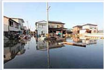
冠水した道路
