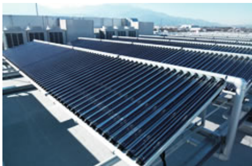
イオンモール甲府昭和様に設置された「ソーラークーリングシステム」
