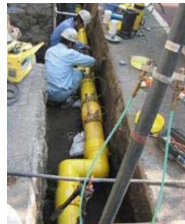
経年ガス管の取り換え
