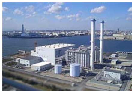
扇島パワー全景
