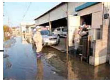
満潮により冠水した現場でガス管の健全性を確認した。(石巻)
