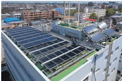
ソーラークーリングシステム（中原ビル）
