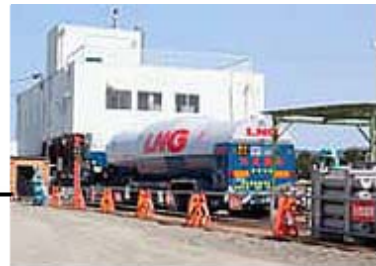
石巻漁港近くの石巻ガス本社は、津波により 1 階が流出。敷地に気化器を設置し、ローリー車による LNG 供給を実施した。
