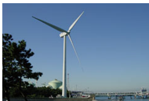
袖ヶ浦風力発電所
