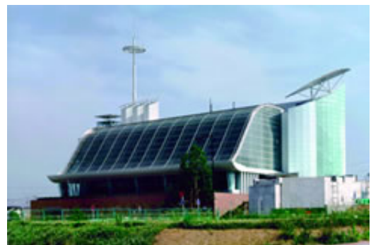
アースポート。太陽熱集熱器やガスエンジンCGS、太陽熱利用ガス吸収冷温水機、太陽光発電パネル蓄電池、次世代照明制御などの技術を複合的に用いてネット・ゼロ・エネルギーを目指す
