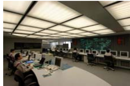
供給指令センター
