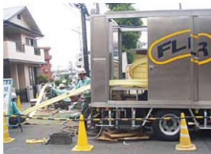
環境に優しいフレックス工法作業風景
