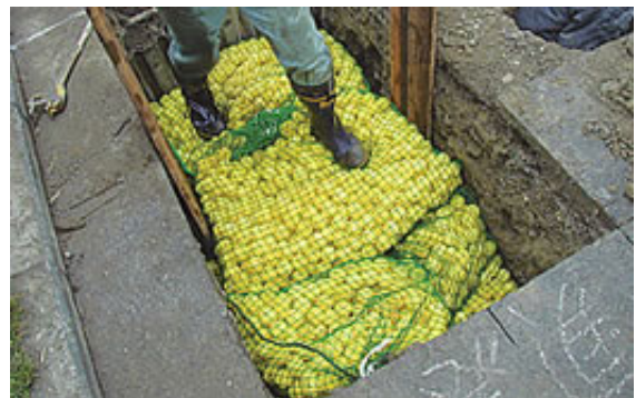
「ECOボール」を利用した導管工事
