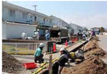
本支管と内管の修繕を並行して行い、早期復旧を図った。(いわき)
