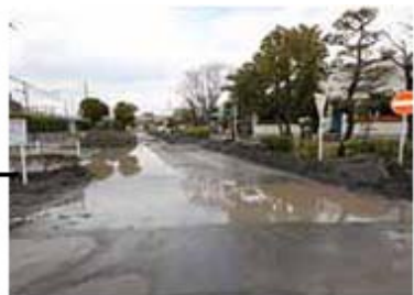
液状化により噴出してきた砂と水が、復旧隊の進捗を阻む。(浦安)
