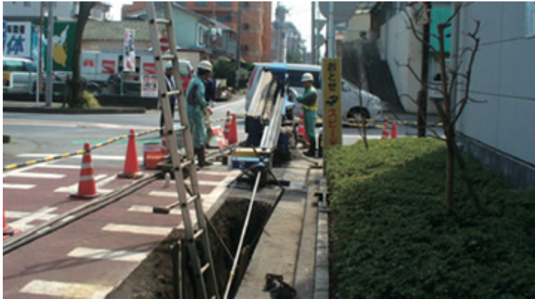
道路を開削せずにガス管を埋設する工法を用いて、掘削土の発生を抑制しています（写真はガス管を推進するための立坑）
