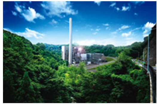
（株）吾妻バイオパワー発電所
