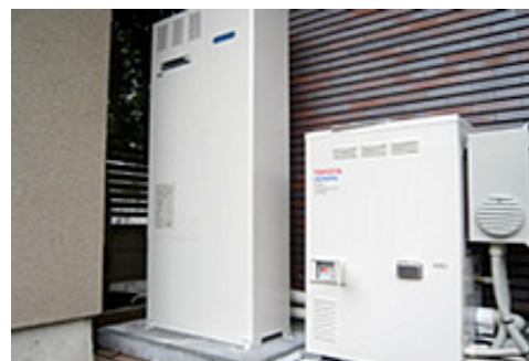
SOFCコージェネレーションシステムの実証研究サイト
