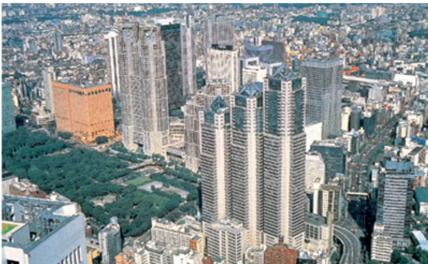
新宿新都心地区地域冷暖房供給エリア
