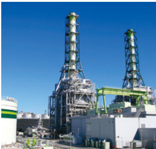
川崎天然ガス発電 (株)
