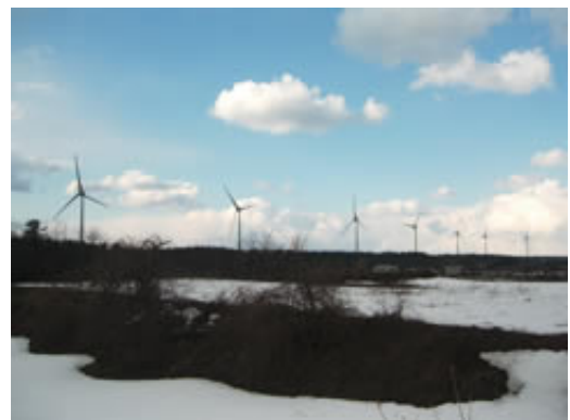
遊佐風力発電所の様子
