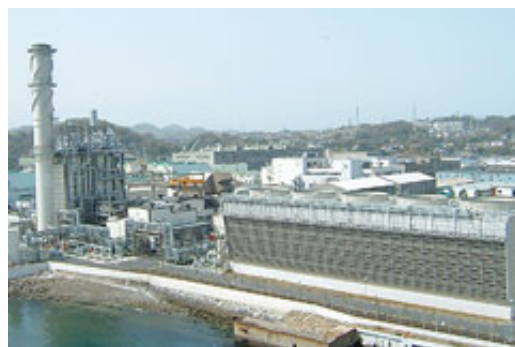
(株)東京ガス横須賀パワー
