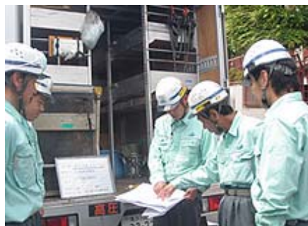
作業前のTBMで施工内容、安全配慮事項等を確認
