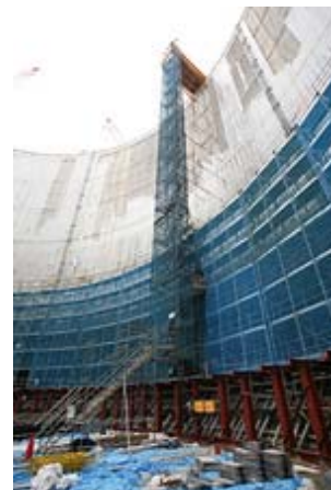
建設中のLNG地下タンク
