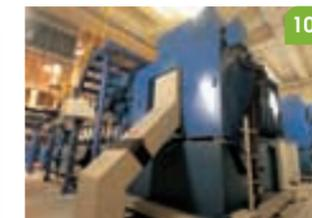
必要な場所で発電し、廃熱を冷暖房や給湯に利用できるガスコージェネレーションシステム
