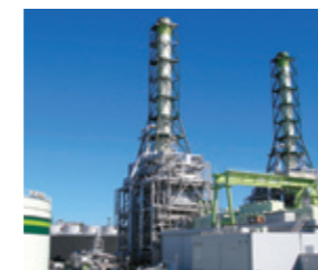
川崎天然ガス発電(株)発電所
