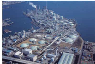
LNGから都市ガスを製造している根岸工場。ほかに扇島工場、袖ヶ浦工場がある
