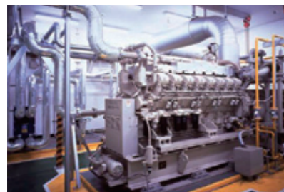
浜松町本社ビル導入と同機種の天然ガスエンジンコージェネレーションシステム。[写真提供:三菱重工工業機汎用機・特車事業本部] (右) エコドライブ実習中の社員
