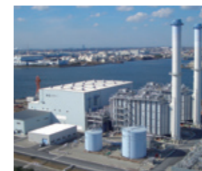
(株)扇島パワー発電所
