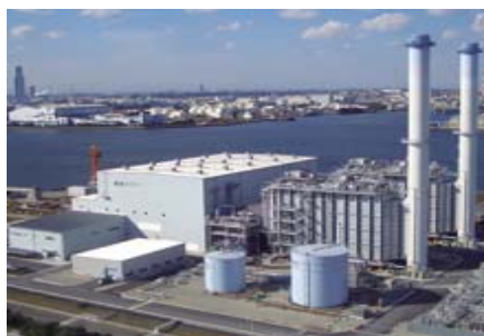
(株)扇島パワー発電所
