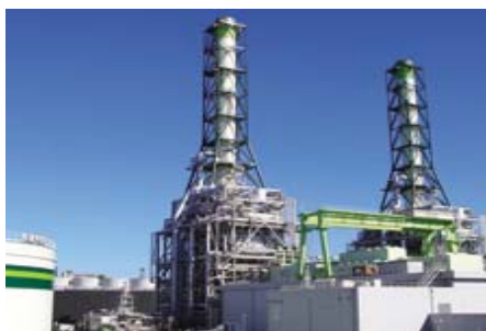
川崎天然ガス(株)発電所
