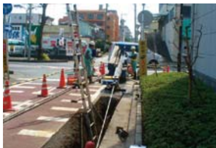
道路を開削せずにガス管を埋設する工法を用いて、掘削土の発生を抑制しています(写真はガス管を推進するための立抗)
