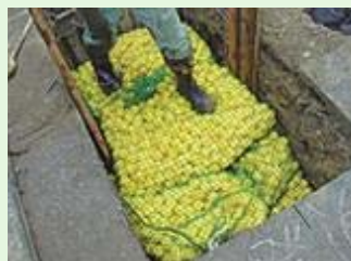
「ECOボール」を利用した 導管工事
