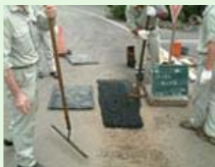
「ホット君II」施工状況
