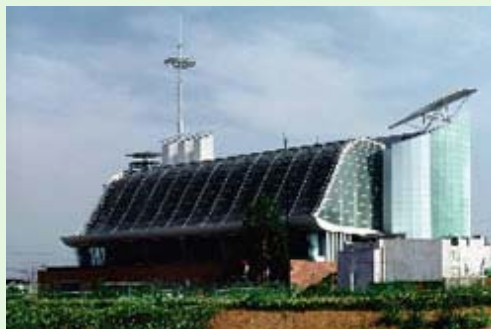
アースポート。太陽熱集熱器やガスエンジンCGS、太陽熱利用ガス吸収冷温水機、太陽光発電パネル、蓄電池、次世代照明制御などの技術を複合的に用いてネット・ゼロ・エネルギーをめざす
