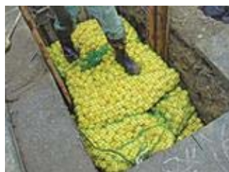
「ECOボール」を利用した導管工事
