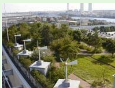
環境エネルギー館 横浜市鶴見区
