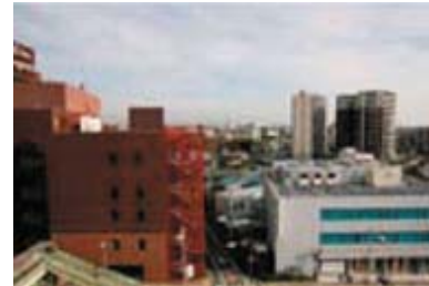
公道を挟んで隣接する東京ガス熊谷支社(右)とマロウドイン熊谷様(左)。熊谷支社の空調需要の低い春や秋、土日に余剰分を融通し、ホテルの給湯に活用
