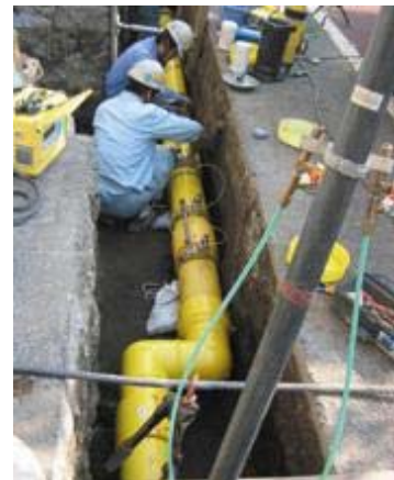
経年ガス管の取り換え
