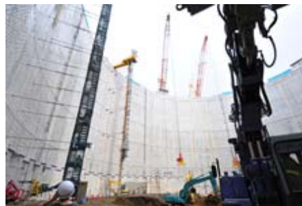
建設中のLNG地下タンク
