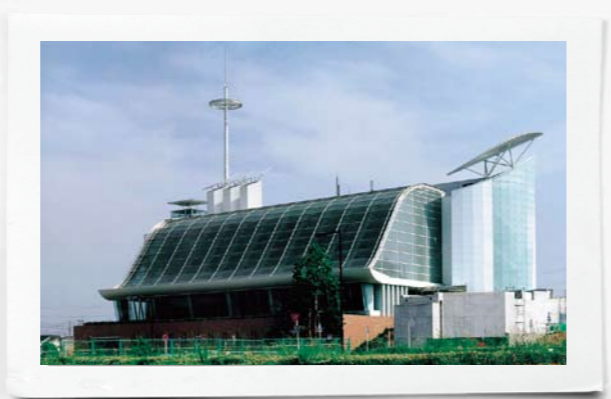
東京ガス港北NTビル「アースポート」は、改修以前もコージェネや自然通風などを利用したトップレベルの省エネビルです。最新の設備・次世代システムによるさらなる高効率化や、太陽熱などの再生可能エネルギーの活用によって、大幅なCO 2 削減がさらに可能であることを実証すべく「ZEB」化を推進中。
