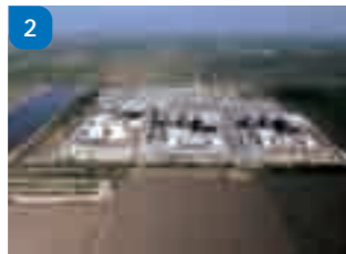
メキシコ・リオブラボ発電所
