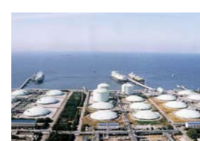
袖ヶ浦工場全景
