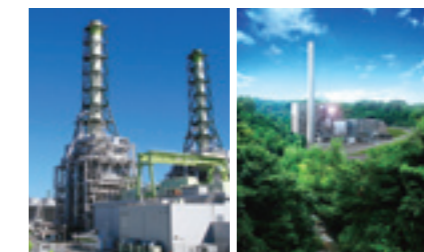
川崎天然ガス(株)発電所 (株)吾妻バイオパワー発電所
