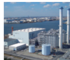
(株)扇島パワー発電所
