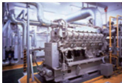
浜松町本社ビル導入と同機種天然ガスエンジンコージェネレーションシステム。[写真提供:三菱重工機械株式会社] (右) エコドライブ実習中の社員
