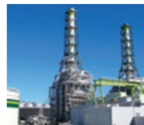
川崎天然ガス(株)発電所
