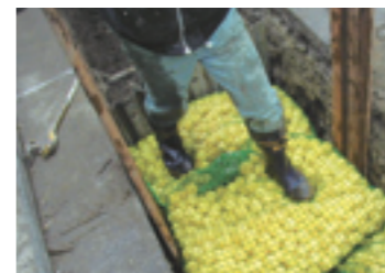
新しい仮埋め戻し材「ECOボール」を利用した導管工事
