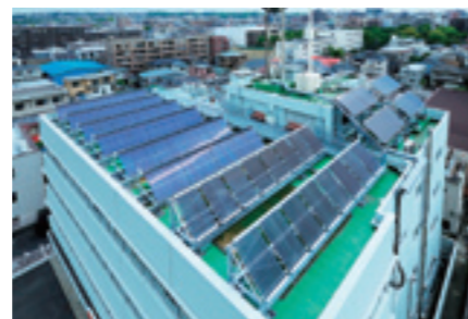
「東京ガス中原ビル(川崎市中原区)の屋上に設置した「高効率ソーラー空調システム」。集熱効率が世界最高クラス(当社調べ)の太陽熱集熱器で集めた熱を冷暖房に利用する
