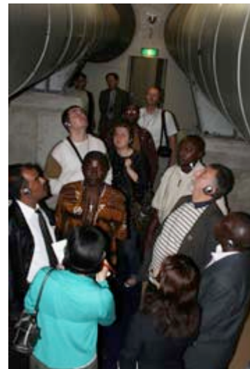
JICA研修生による 新宿地域冷暖房センター見学
