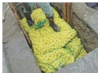
「ECOボール」を利用した導管工事
