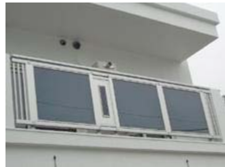
手すり一体型ユニット設置状況
