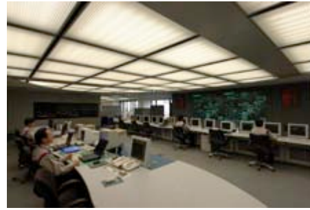
供給指令センター
