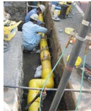
経年ガス管の取り換え
