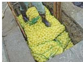
「ECOボール」を利用した 導管工事
