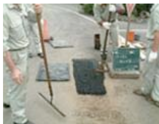
「ホット君II」施工状況
