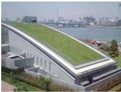
がすてなーにガスの科学館 東京都江東区
