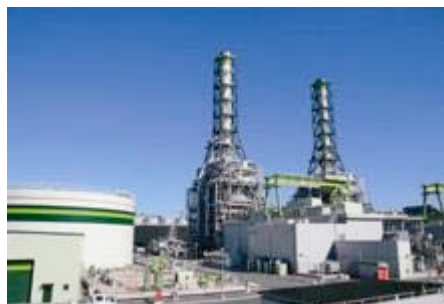
川崎天然ガス発電（株） 川崎天然ガス発電所
