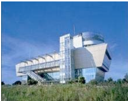
環境エネルギー館
