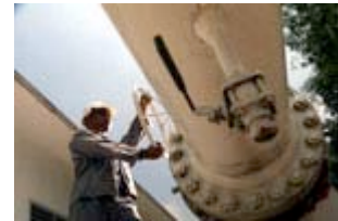
パイプのバルブを操作する ガスマレーシア社社員
