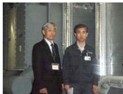
ガス吸収冷温水機の前で（株）東京ドーム 施設部 設備グループ長 吉川俊朗様（右）と
