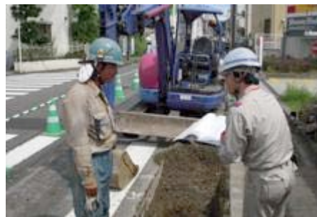
照会工事の現場風景
