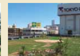
東京ガス 浦和ビル うらわ四季彩ガーデン さいたま市南区
