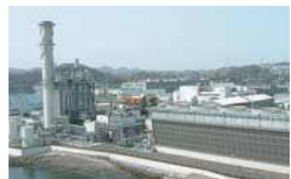
(株)東京ガス横須賀パワー
