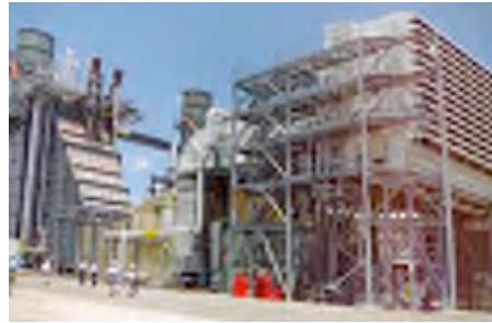
メキシコ パヒオ発電所
