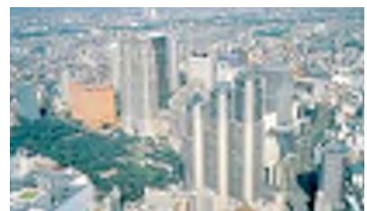
新宿地域冷暖房供給工リア
