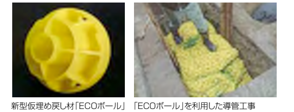
新型仮埋め戻し材「ECOボール」 「ECOボール」を利用した導管工事
