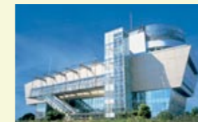
環境エネルギー館
