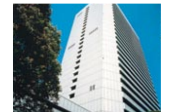
浜松町本社ビル
