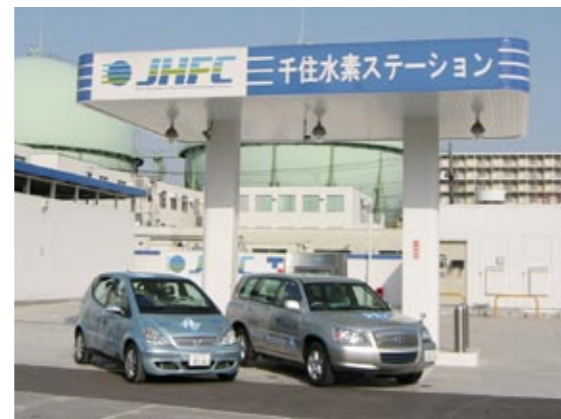
水素ステーション外観
