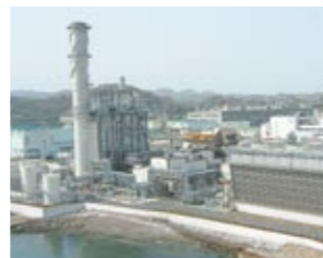
(株)東京ガス横須賀パワー
