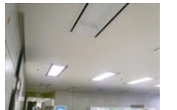
事務所内の部分消灯
