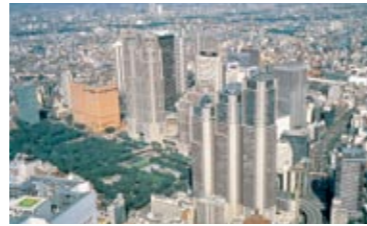
新宿地域冷暖房供給エリア
