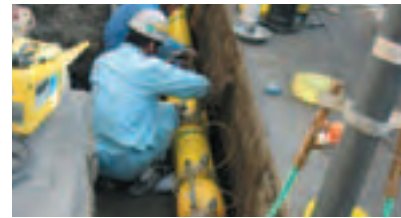
経年ガス管取り替え
