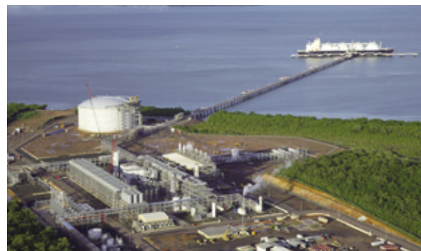
LNG液化基地
