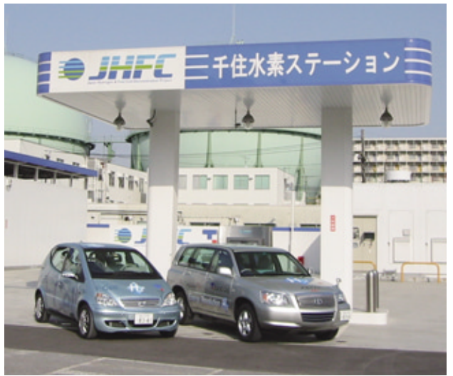
水素ステーション外観
