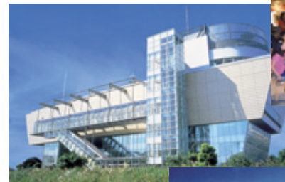
環境エネルギー館
