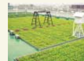
中原ビルの屋上緑化
