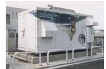
燃料電池の中で既に実用化されているものが「りん酸形」です。ガスコージェネレーションシステムの発電装置として、様々な場所で活躍しています。2001年度末で当社管内への累計導入台数は60台、発電容量は9,680kWとなっています。また、当社は今後の分散型発電の時代に向けて、「固体高分子形」を用いた家庭用の燃料電池コージェネレーションシステムの開発も推進しています(P26)。
