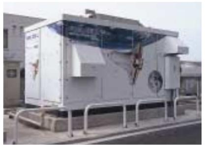
燃料電池の中で既に実用化されているものが「りん酸形」です。ガスコージェネレーションシステムの発電装置として、様々な場所で活躍しています。2000年度末で当社管内への累計導入台数は57台、発電容量は9,180kWとなっています。また、当社は今後の分散型発電の時代に向けて、「固体高分子形」を用いた家庭用の燃料電池コージェネレーションシステムの開発も推進しています(P34)。
