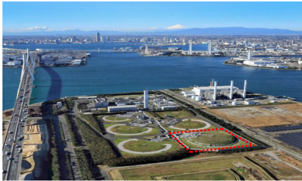
扇島 LNG 基地全景 (点線枠が世界最大地下式 LNG タンク)
