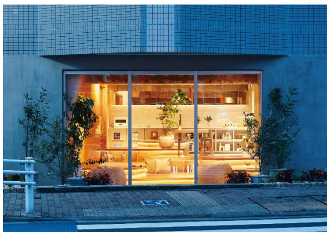
<外観竣工写真>
