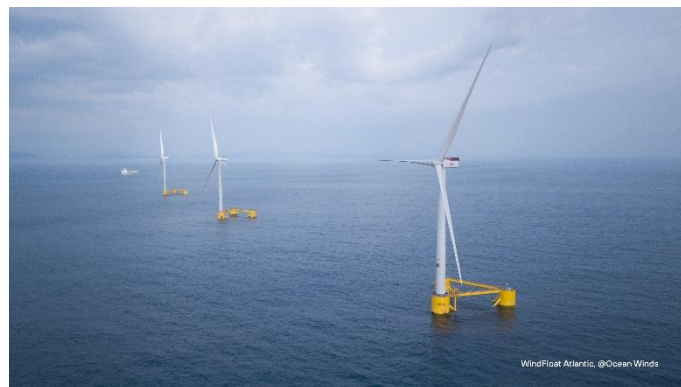
プリンシプル・パワー社の浮体技術を採用した洋上風力発電所「ウインドフロート・アトランティック（WindFloat Atlantic）」
