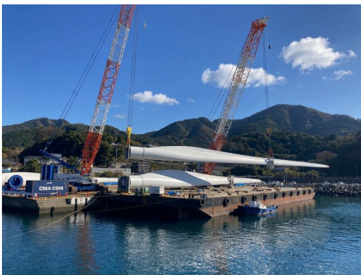
峇北・天草風力発電所の建設の様子（レノバ提供）
