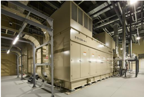
停電時も発電可能なガスコージェネレーションシステム
