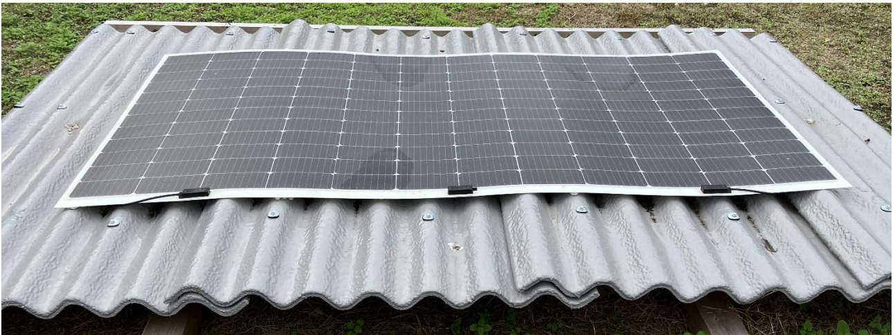
スレート屋根への設置検証の様子
