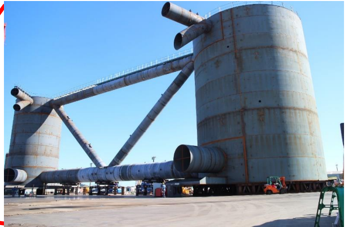
製作した浮体式基礎モックアップの外観
