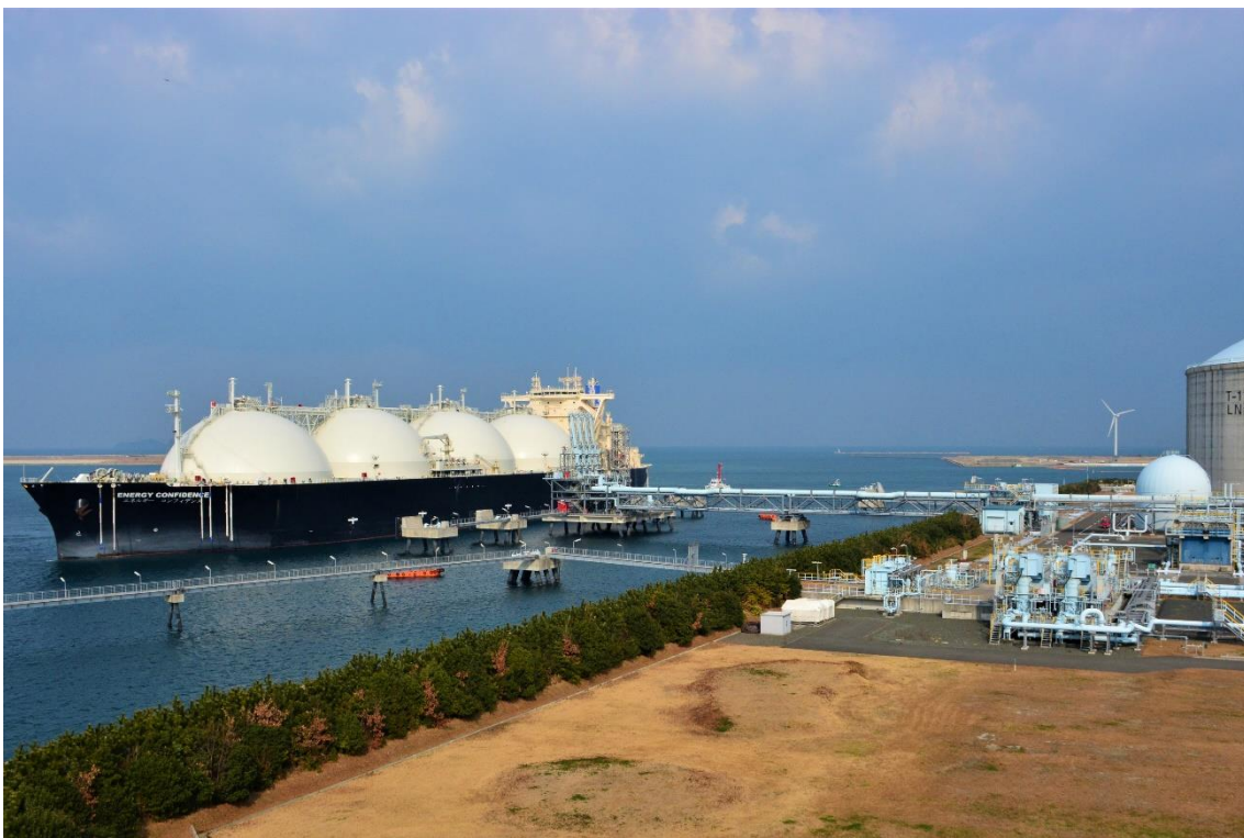
<LNG 船がひびき LNG 基地へ入港した様子>
