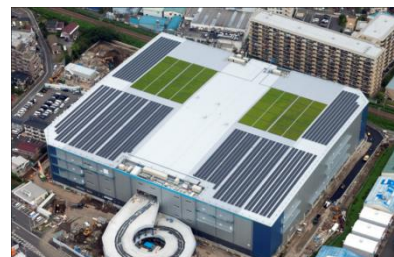
神奈川・中山屋上ソーラ発電所
