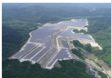
宮城・黒川メガソーラー発電所
