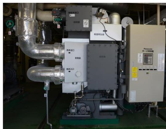
CGSの廃熱で製造した蒸気を利用して冷房を行う
