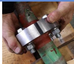
②治具をパッキン部に設置
