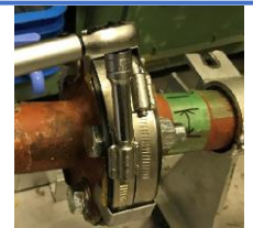
④トルクレンチによりバンドを締め付
