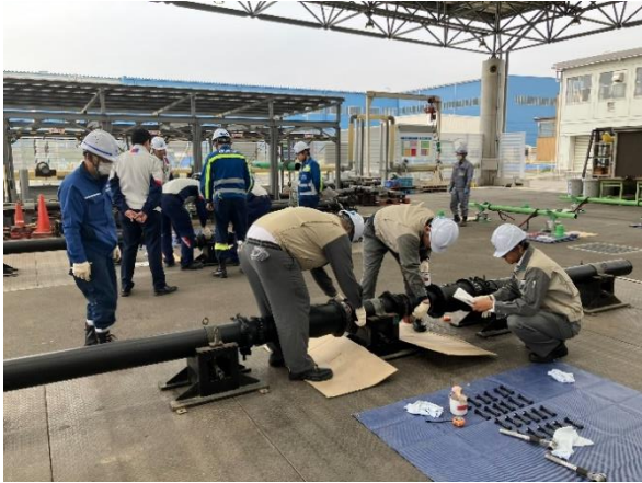
配管の接合訓練
