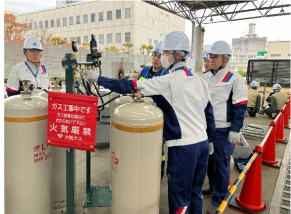
移動式ガス発生設備の組立訓練
