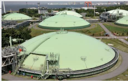
LNGタンク外観
