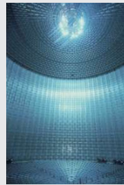
LNGタンク内観
