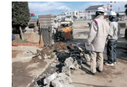
お客様のご協力のもと、敷地内のガス管修理を実施。
