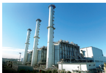
Ohgishima Power Co., Ltd.
