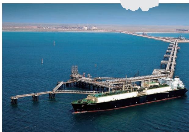
Gorgon LNG Project
