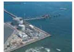
Hitachi LNG Terminal
