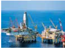
Darwin LNG Project (Bayu-Undan Gas Field)
