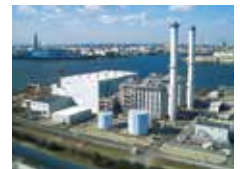
Ohgishima Power Co., Ltd.
