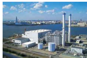
3 Ohgishima Power Co., Ltd.
