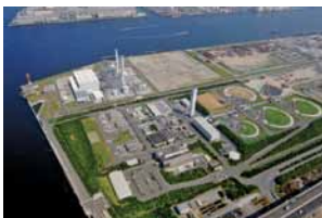
2 Ohgishima LNG Terminal
