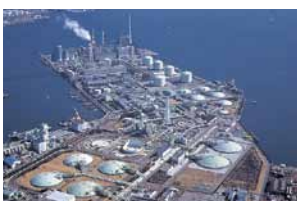
3 Negishi LNG Terminal
