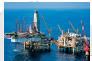
Darwin LNG Project
