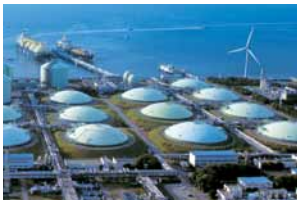
1 Sodegaura LNG Terminal
