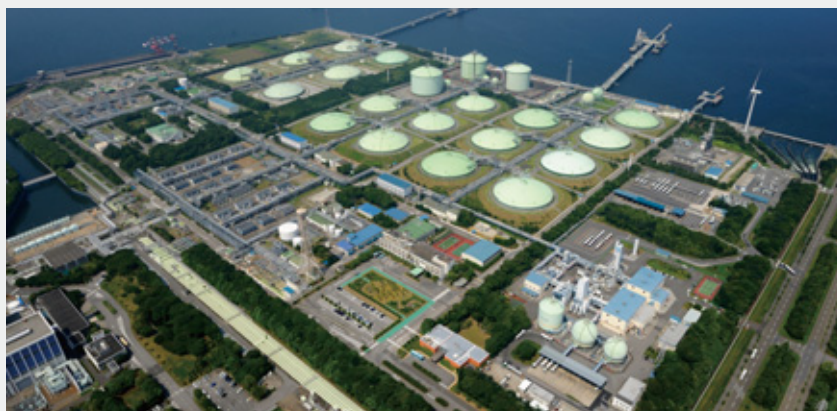
袖ヶ浦LNG基地
